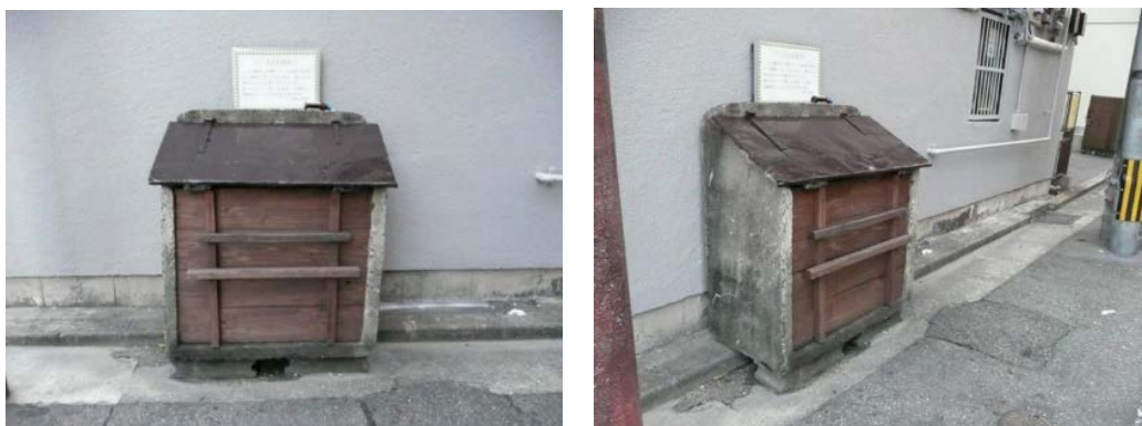
写真1（左）、写真2（右）：コンクリート製ごみ箱
