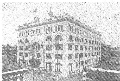
図3 三越本店新館の完成写真
