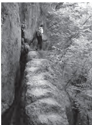
写真12 岩壁を割る用水路
