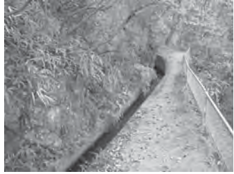
写真10 溪谷沿いの用水路
