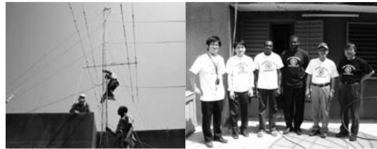
図12 アマチュア無線局設営の様子(アンテナ工事(左)、参加者(右))
