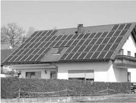
写真1 太陽光発電パネル
