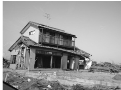
写真5 全壊状態の被災家屋
