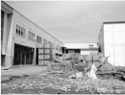
写真34 港湾内事業所の状況
