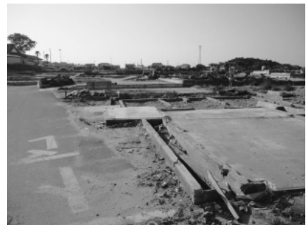
写真9 漁港背後の建物跡
