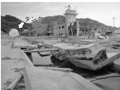
写真41 岸壁付近状況と横転したタンク
