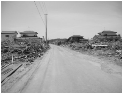
写真22 全壊状態の住宅街
