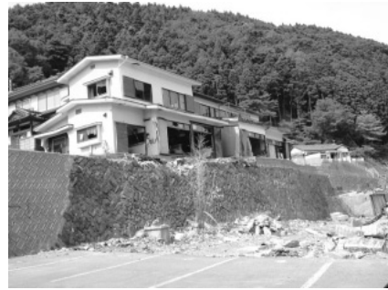
写真36 全壊状態の高台の家屋
