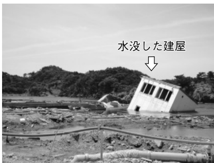
写真23 水没状態の建屋
