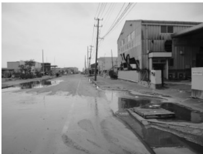
写真35 上げ潮時に冠水した道路
