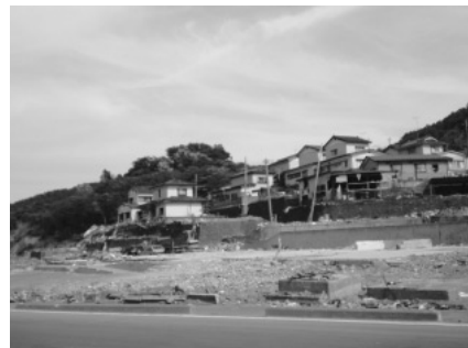
写真37 壊滅状態の平地と高台の状況
