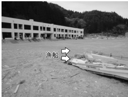
写真43 被災した小学校の状況
