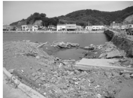
写真29 沿岸部道路の崩壊箇所
