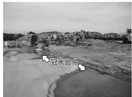
写真33 瓦礫の仮置場と冠水箇所
