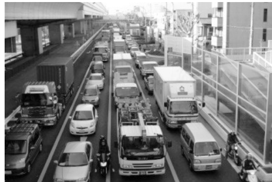
図6 国道43号線の現況(上部は阪神高速3号線)
