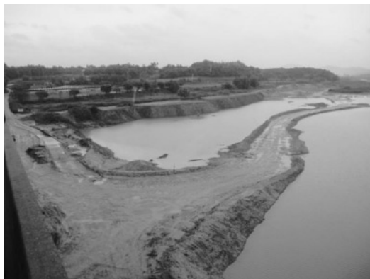
写真19 南漢江の河川改修現場(河川敷方向)
