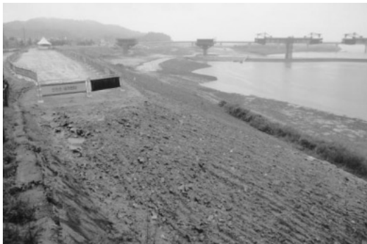
写真9 南漢江の第一河口堰建設現場(河川敷側)
