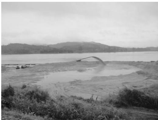
写真12 南漢江の浚渫工事現場(右側方向)
