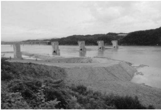
写真15 南漢江の第三河口堰建設現場(左側方向)
