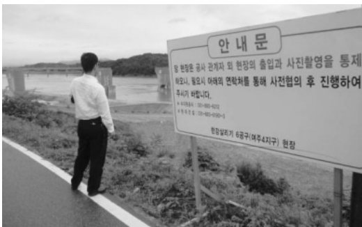
写真16 南漢江の第三河口堰建設現場(道路沿い)
