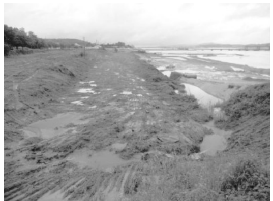
写真14 南漢江の浚渫工事現場(左側方向)
