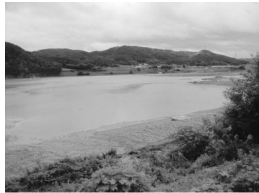
写真17 南漢江の第三河口堰建設現場(右側方向)
