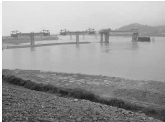
写真10 南漢江の第一河口堰建設現場(河川中央)
