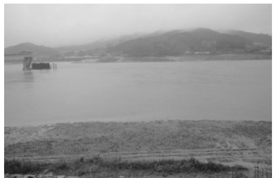
写真11 南漢江の第一河口堰建設現場(対岸方向)
