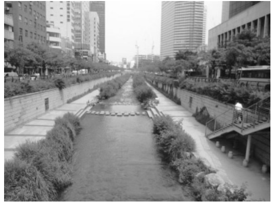
写真3 上流起点から約1.5km地点の下流方向
