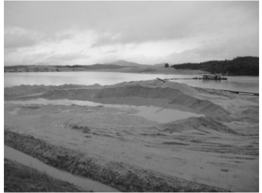
写真13 南漢江の浚渫工事現場(中央方向)
