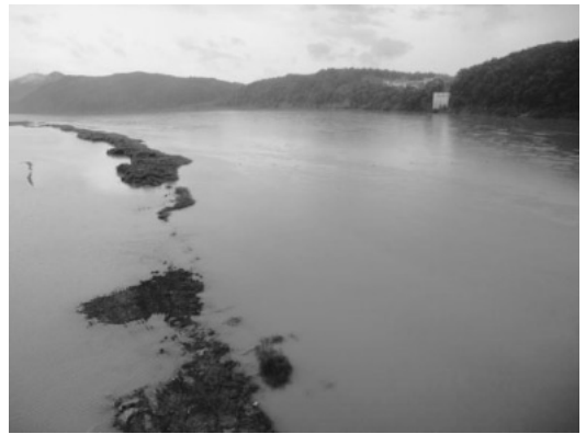
写真20 南漢江の河川改修現場(河川中央から対岸方向)
