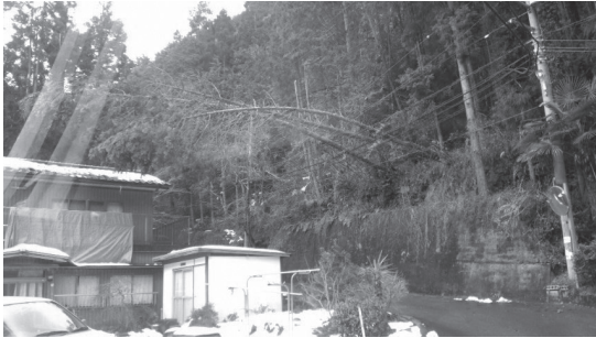
写真5 電線に倒れかかる樹木
