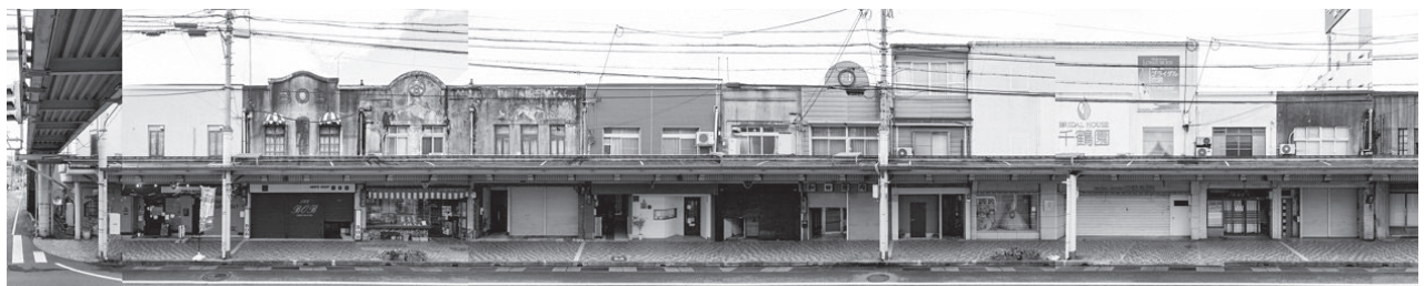
図 12 大開通りに建設された11軒長屋 面路部の耐火建築のみが長屋化され、その裏側は木造の町屋となり、家屋ごとに独立した構造になっている。 ©Tetsuya & Tomoyo Hayashiguchi.
