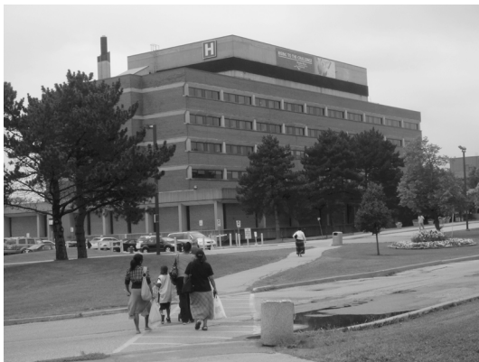
写真9 救急病院 Humber River Regional Hospital の 外観 (2010年7月23日撮影)
