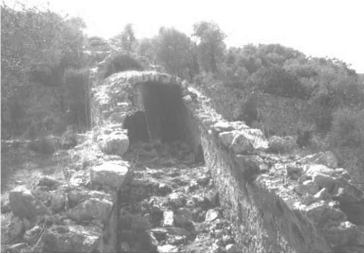
写真 2 廊下（長壁との交差点）
